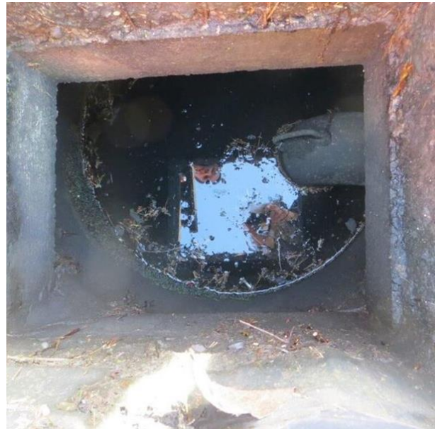
Schacht mit Tauchbogen
