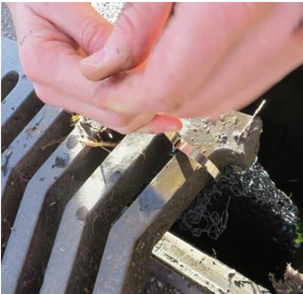
Matte mit Kabelbinder festziehen.
