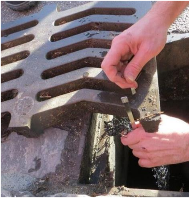
Matte mit Metallkabelbinder an Deckel befestigen.
