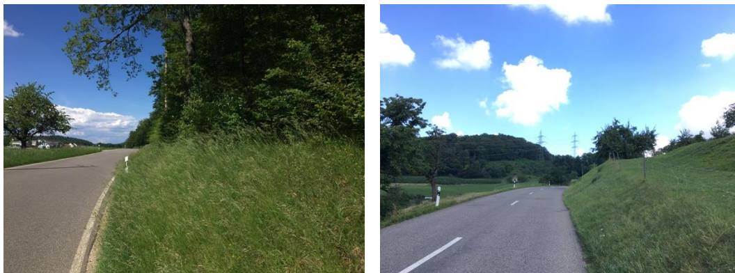
Abb. 12: Langgezogene Strassenböschungen zwischen Wittinsburg und Känerkinden (links) und entlang der Rheinfelderstrasse in Sissach (rechts), wo Anpassungen der Pflege zur Sicherung der Naturwerte vom Tiefbauamt eingeleitet werden. Fotos M. Knecht.
