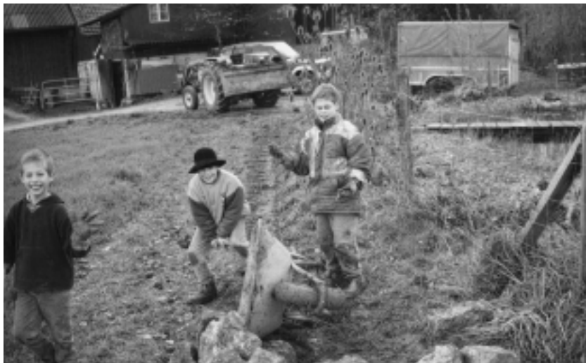
Auf dem Hof Horn in Häfelfingen bauten wir eine Trockensteinmauer. (Foto: Christoph Jenni)
