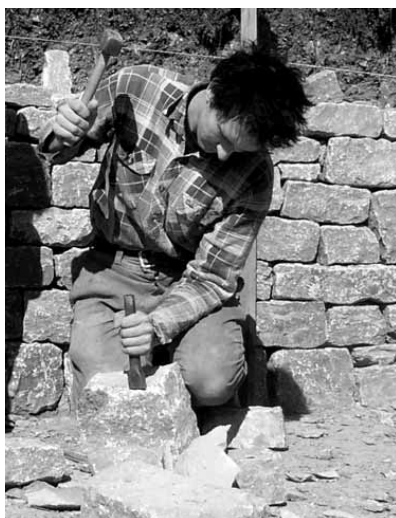
Damit der Stein auf der Mauer nicht wackelt, muss er vorher sorgfältig behauen werden.
