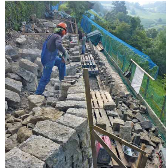
Trockenmauern im steilen Gelände: Notfallmässig musste im Rebberg Dielenberg in Oberdorf eine wichtige eingestürzte Mauer saniert werden. Dies war der Startschuss für das 5-Jahresprojekt, bei welchem dank der Unterstützung des Fonds Landschaft Schweiz, des Swisslos-Fonds, der Walder Bachmann-Stiftung und der Gemeinde Oberdorf in Zusammenarbeit mit dem Weinbauverein ein Teil der maroden Hangsicherungen durch ökologisch wertvolle Trockenmauern ersetzt werden.
