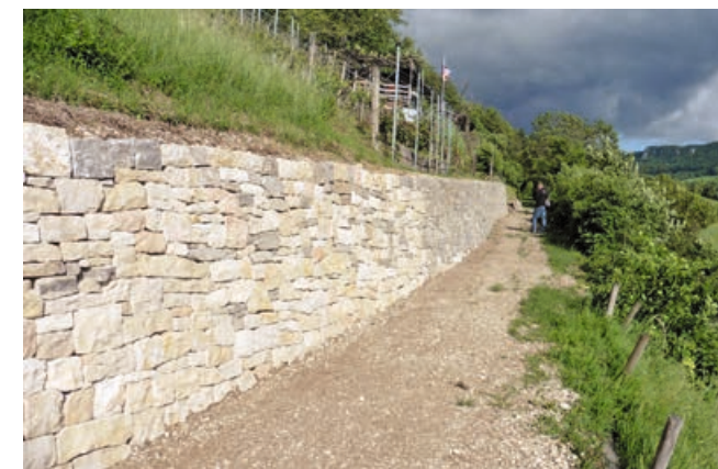
Auf der Parzelle von Pro Natura Baselland wurde im Rebberg Dielenberg in Oberdorf im Rahmen des Mehrjahresprojekts eine Trockensteinmauer mit Steinen aus dem Laufental neu erstellt.
